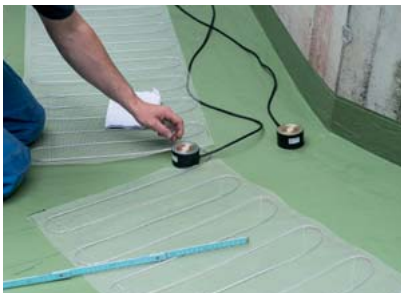
Platzieren der beiden Sensoren für Temperatur- und Feuchtigkeits-Messung.
