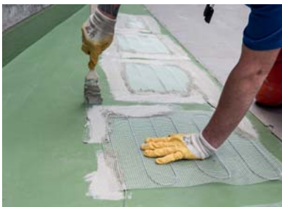
Fixieren der platzierten Heizmatten mit Wecryl 810 Spachtel.
