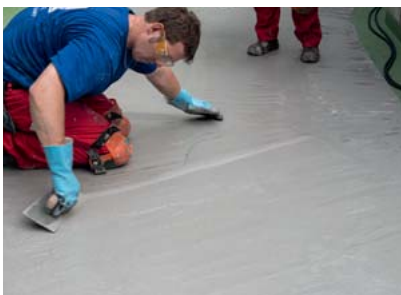
Aufbringen einer zweiten Lage Verlaufmörtel auf den Heizmatten.
