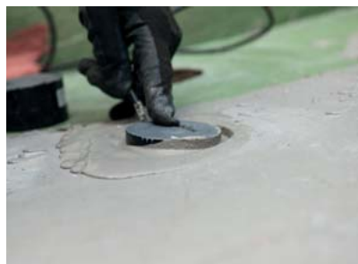
Der Einbau der Sensoren muss waagrecht geschehen.
