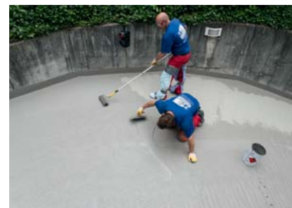
Aufziehen und abrollen des mechanisch hoch belastbaren Strukturbelags.
