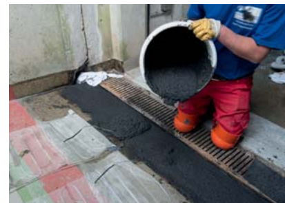
Am Fuß der Rampe enden die Heizmatten und deren Kabelenden werden im Wecryl 242 Mörtel eingebettet.
